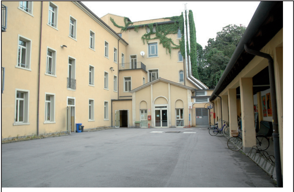
Il cortile interno con la “Chiesetta”
